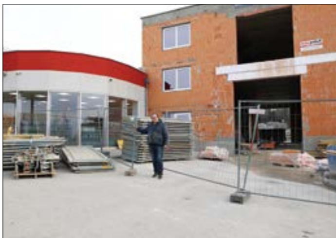
GET Senior-Chef Karl Haider vor der Baustelle im Gewerbepark. Bereits im Frühjahr können hier die ersten Reifen zur Aufbewahrung gebracht werden.
