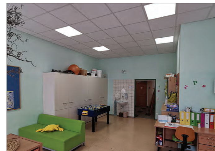
Das hellere Licht (von 200 auf 500 Lux) in den Klassenräumen führt laut internationalen Studien zu einer durchschnittlichen Steigerung der Leistungsfähigkeit um 8%. Möglich gemacht durch die Technik der Firma Cleen Energy aus Haag. Fotos: Cleen Energy
